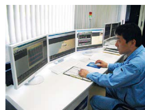
浜田市では「やくも水神Gシリーズ」を使い、上水道・簡易水道・工業用水182施設を一元管理している
